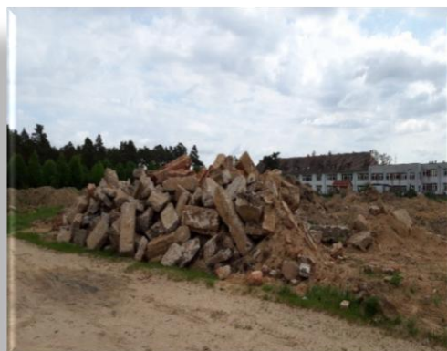
W trakcie inwestycji
