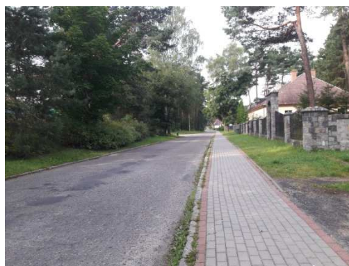
Fot. 18 ul. Sosnowa
