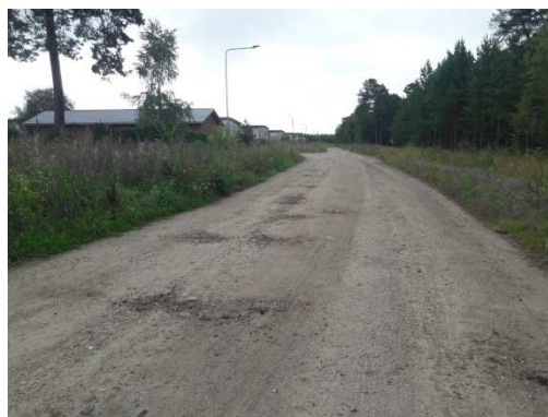
Fot. 22 ul. Wodociągowa
