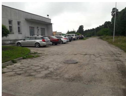
Fot. 24 ul. Wodociągowa
