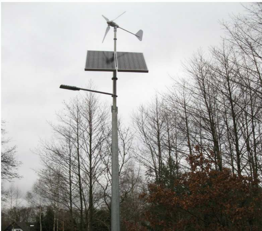
Budowa 50szt. lamp ulicznych zasilanych energią ze źródeł odnawialnych na terenie Gminy Borne Sulinowo
