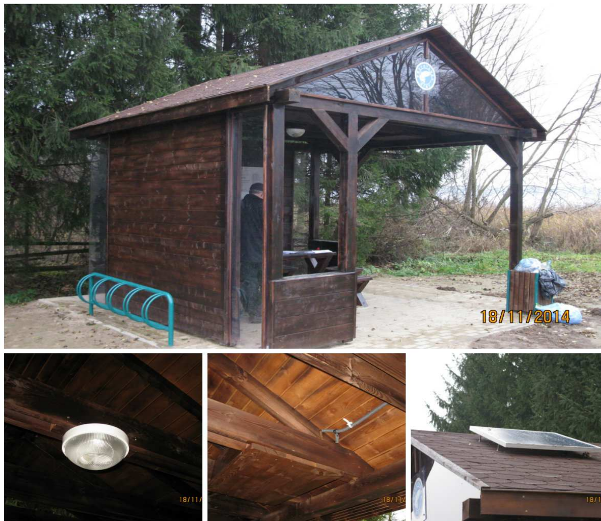
Montaż oświetlenia wiaty zlokalizowanej na parkingu przy jeziorze Pile w m. Piława
