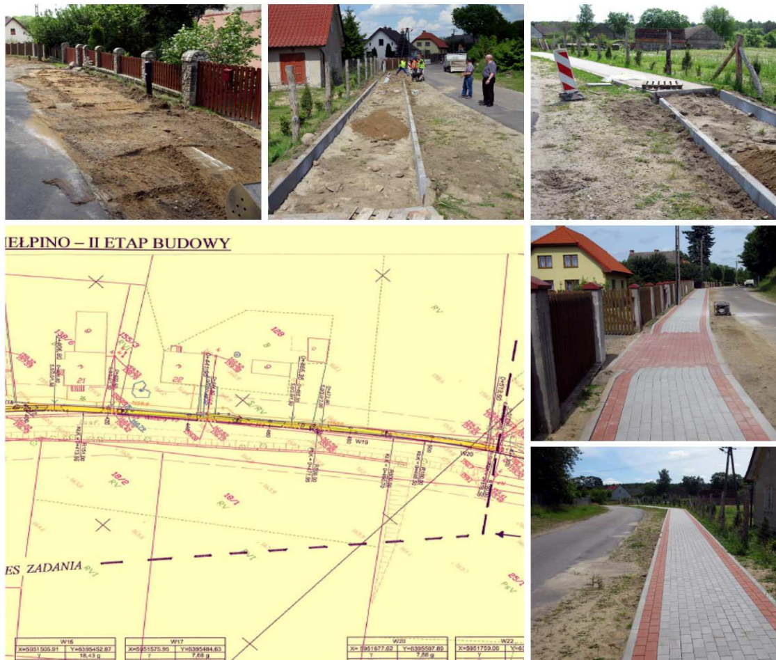
Budowa chodnika w m. Kiełpino – II etap budowy
