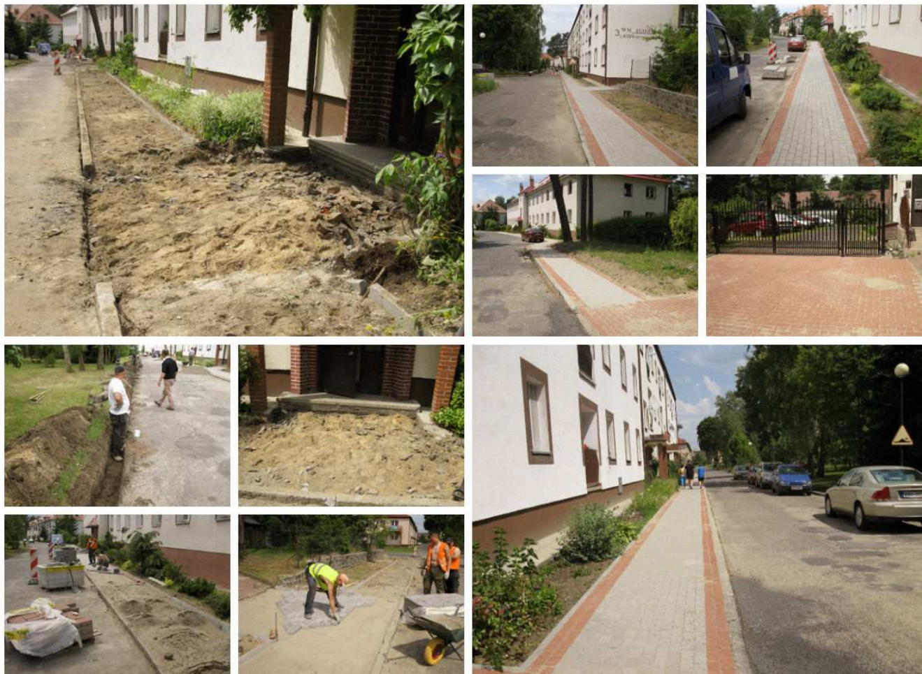
Wykonanie robót budowlanych związanych z remontem chodnika przy ul. Wyszyńskiego 3 i 4 w Bornem Sulinowie
