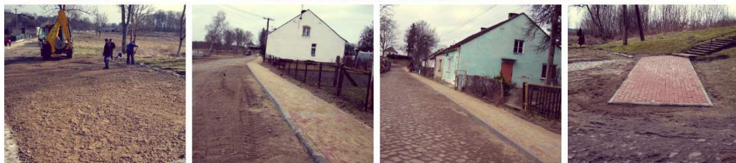
Budowa chodnika w m. Dąbie
