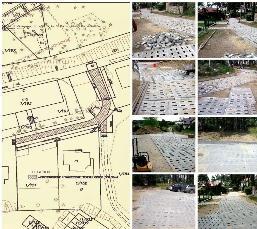
Utwardzenie płytami betonowymi ulicy Wrzosowej w Bornem Sulinowie
