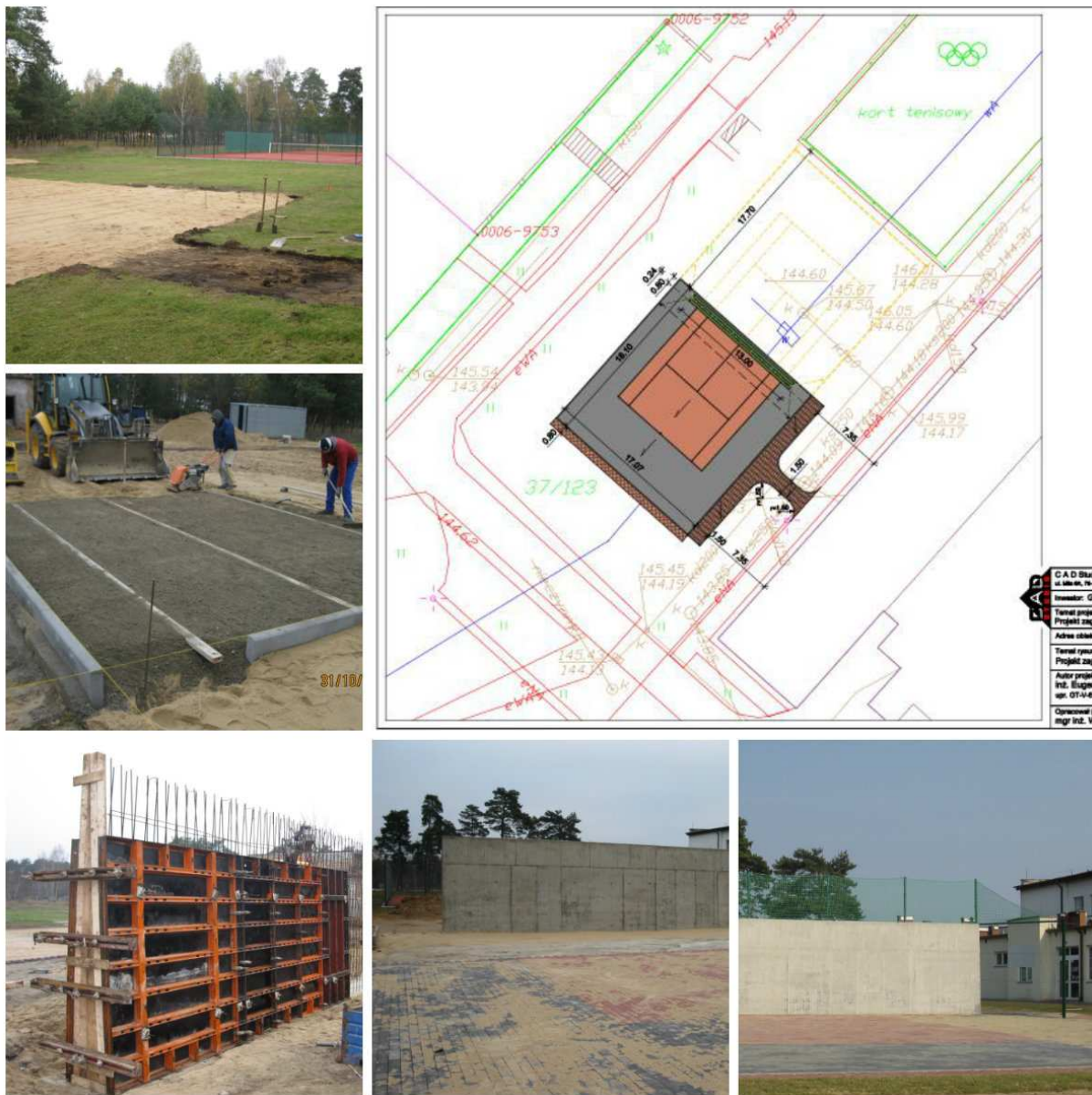
Budowa boiska ( treningowego do tenisa ziemnego ) na terenie dz. nr 37/123 obręb Borne 06 w Bornem Sulnowie
