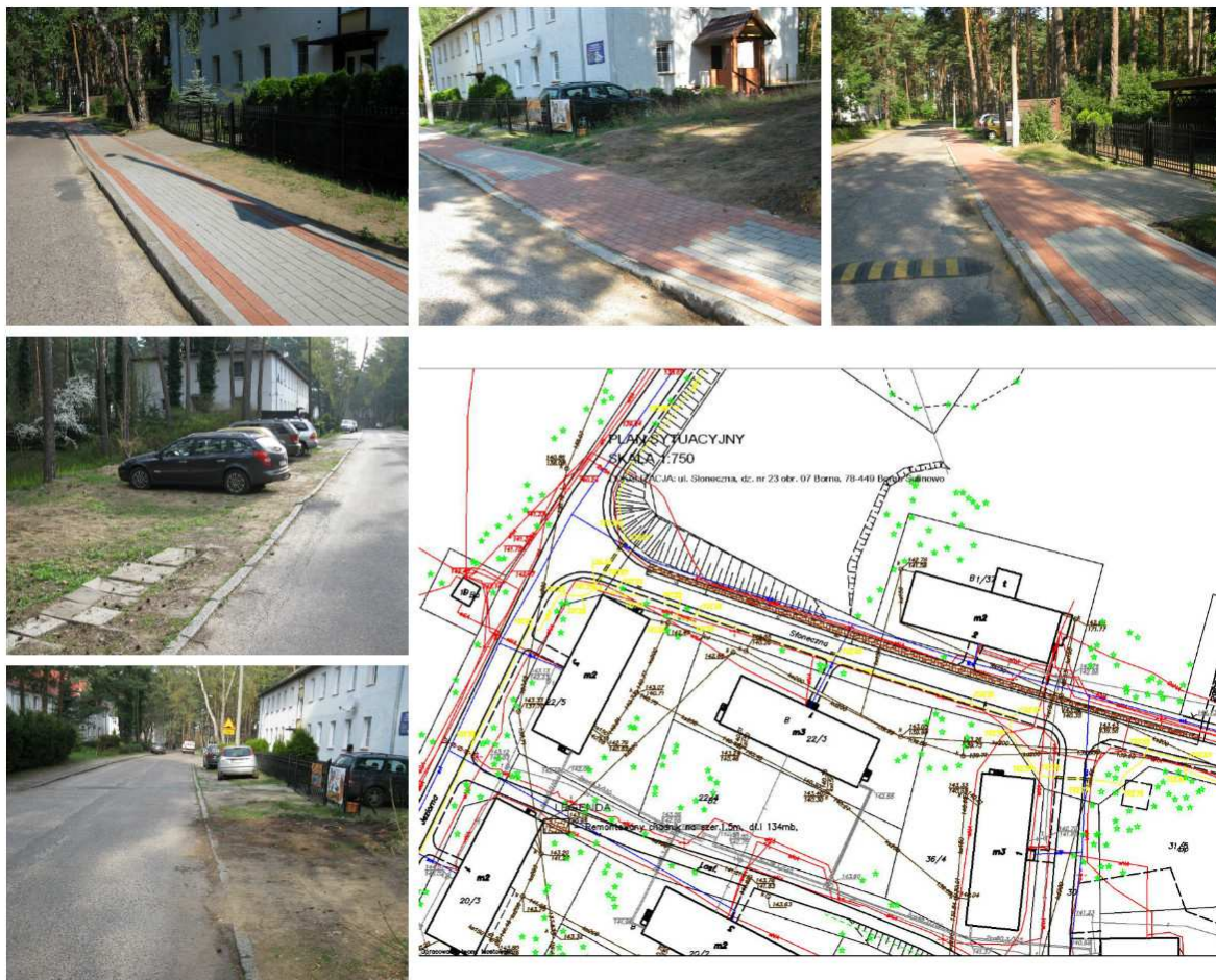
Remont chodnika przy ul. Słonecznej 2 w Bornem Sulinowie
