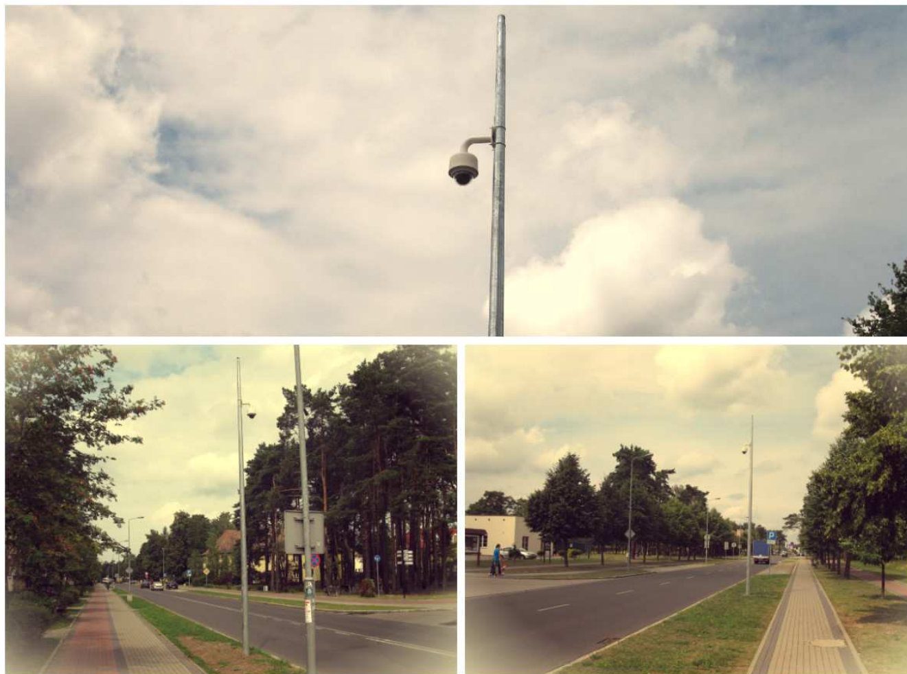
Rozbudowa systemu monitoringu wizyjnego w Bornem Sulinowie
