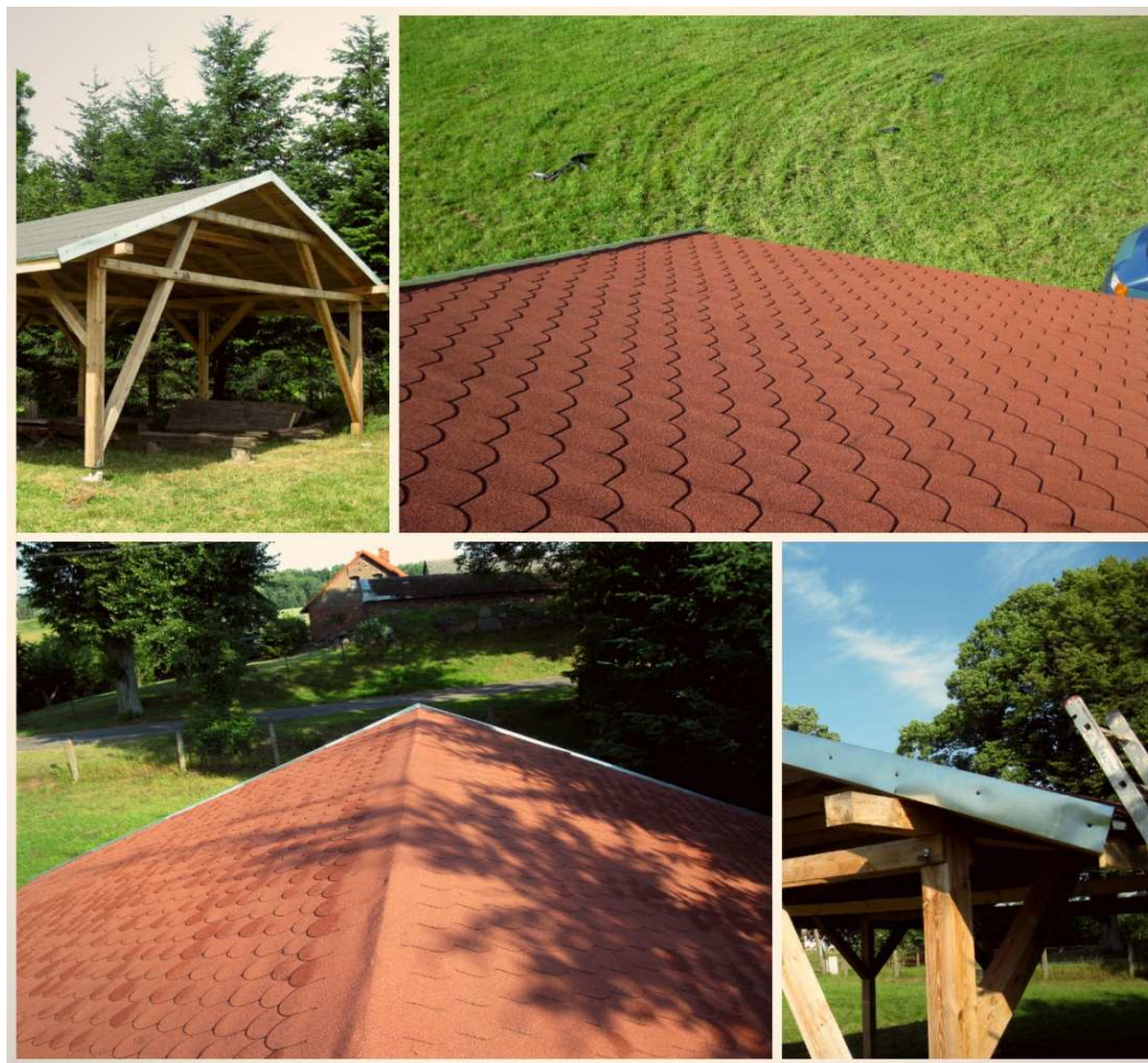
Pokrycie dachu wiaty rekreacyjnej na boisku sportowym w m. Łączno
