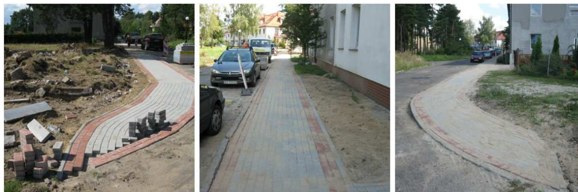
Wykonanie robót budowlanych związanych z remontem chodnika przy ul. J. Słowackiego 5 w Bornem Sulinowie
