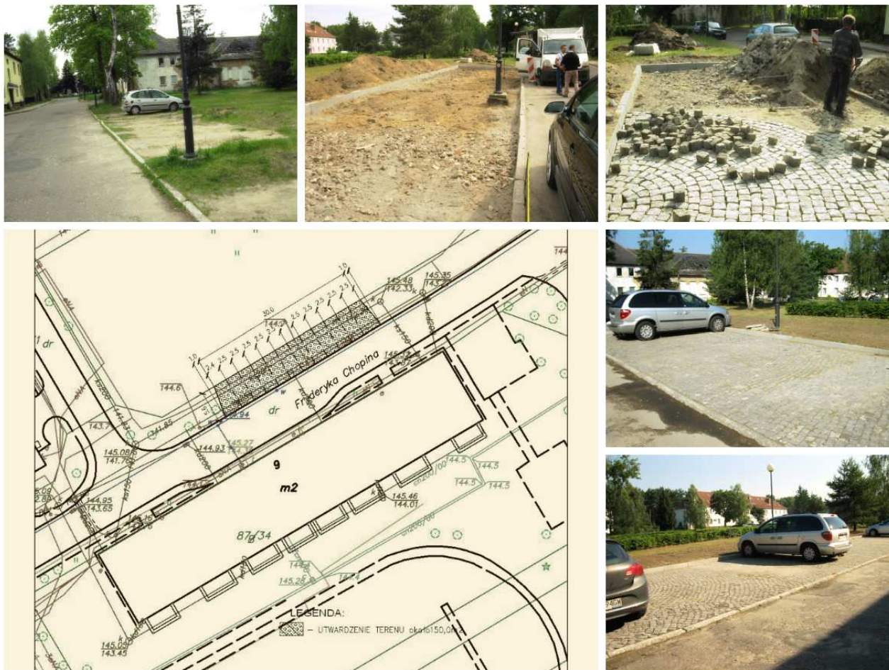
Wykonanie ogólnodostępnych miejsc postojowych dla samochodów osobowych naprzeciwko budynku wielorodzinnego przy ul. Fryderyka Chopina 6 – wraz ze wspólnotą mieszkaniową
