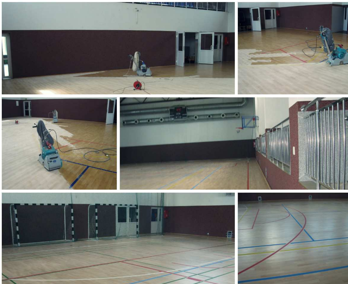
Renowacja podłogi sportowej w Bornem Sulinowie przy Al. Niepodległości 21
